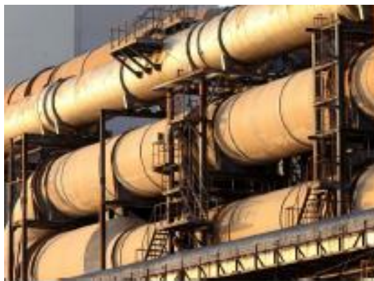
配管(ダクト)内部点検
