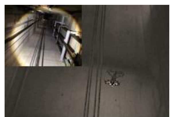
エレベーター・ 立体駐車場の点検
