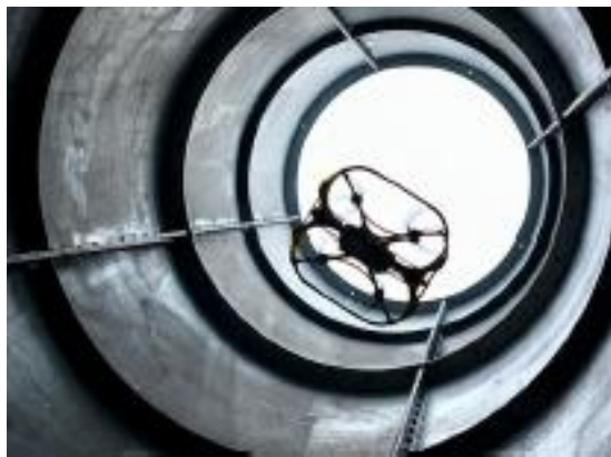
煙突 内部の点検
