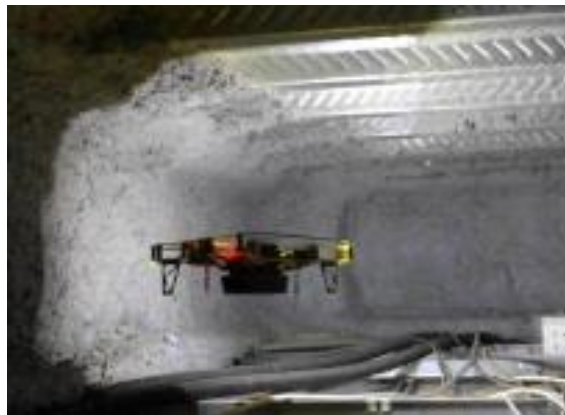
天井裏・地下ピット
