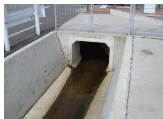
BOXカルバートの内部
