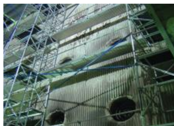
ボイラー内部の点検
